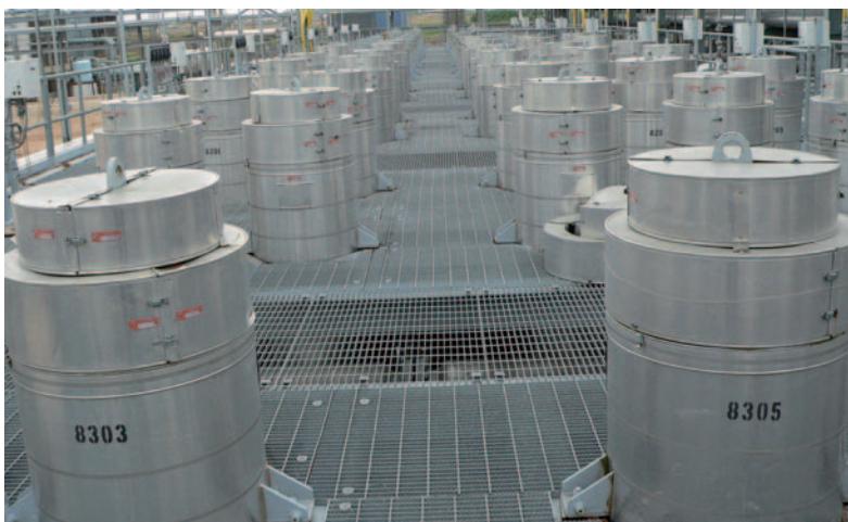
Figuur 5 Kooldioxide terugwin installatie in Snyder, Texas
